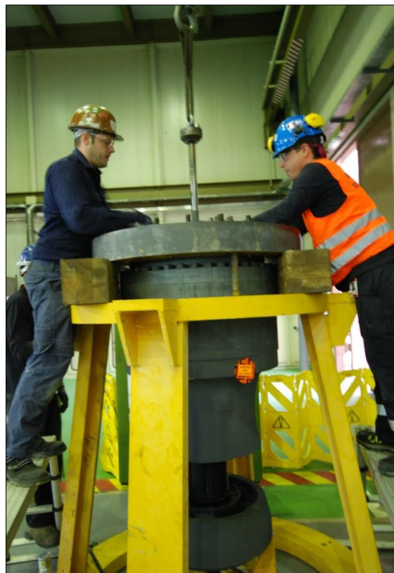
Revisión válvula aislamiento vapor principal.
