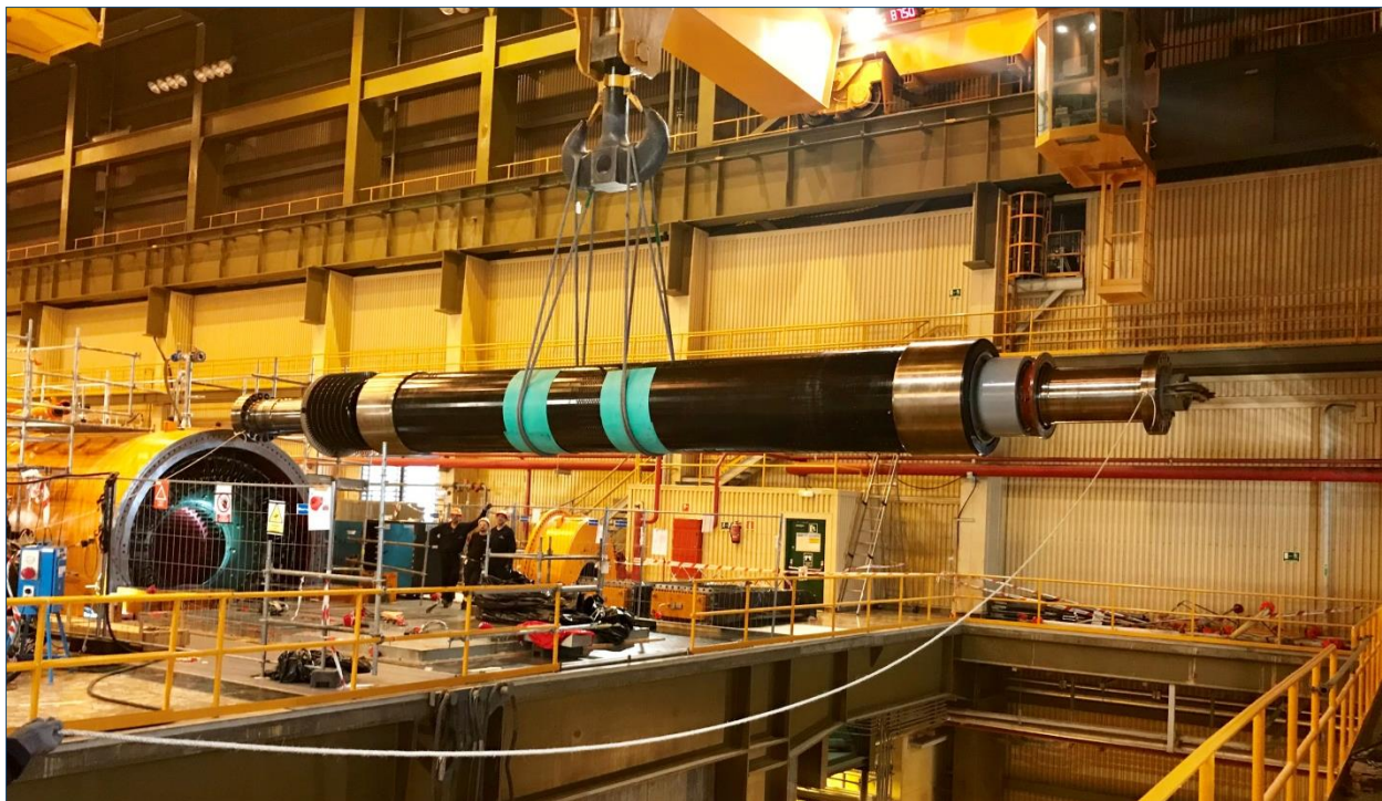
Maniobra de colocación del rotor del alternador.
