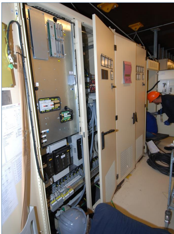
Cambio convertidor rotativo por ondulator estático.
