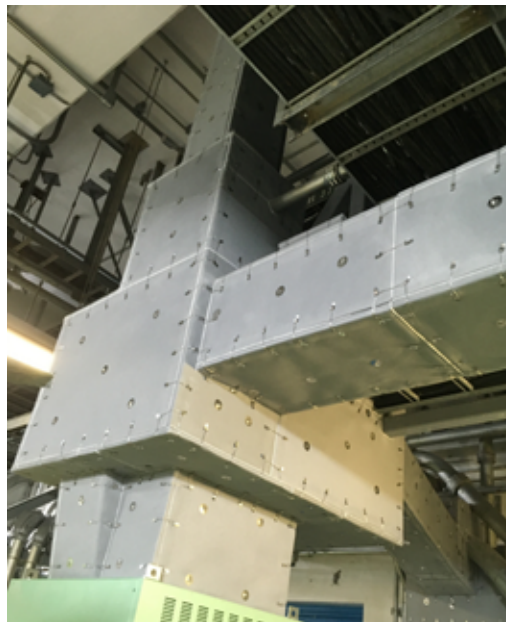
En CN Almaraz se ha finalizado la instalación de las Modificaciones de Diseño asociadas a la transición a la normativa de PCI (NFPA 805)
