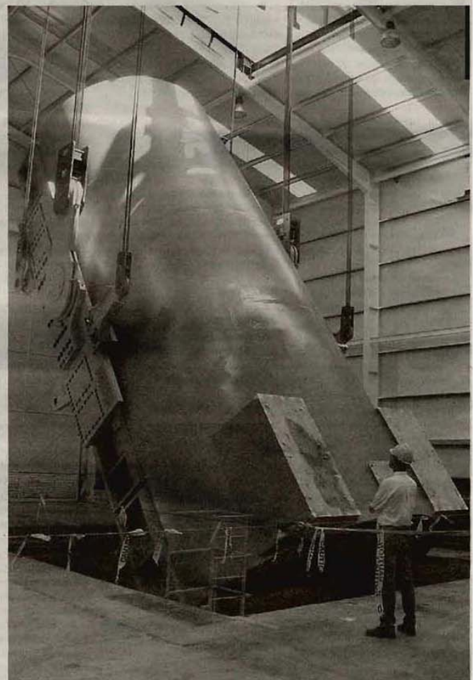
Un operario observa la maniobra de la grúa polar con el nuevo alternador. / LA RUE
